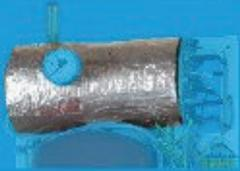
Isolamento della caldaia in lana di roccia  $\lambda 0,042\text{W/mK}$
